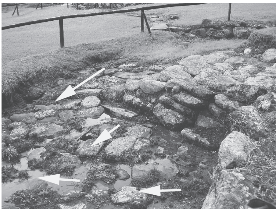
Fig. 15: Detalle de la foto 14. Agua de escorrentía superficial. Las flechas señalan el flujo de agua.
