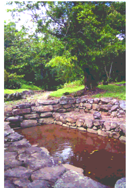
Figura 11. Tanque de captación de agua.
