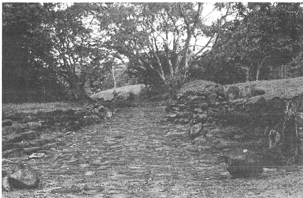
Para las plataformas, terrazas y montículos, donde tenían problemas con las pendientes del terreno, fue necesario el uso de sistemas de muros de contención para proporcionar áreas planas, como parte de las diferentes soluciones constructivas del sitio.
